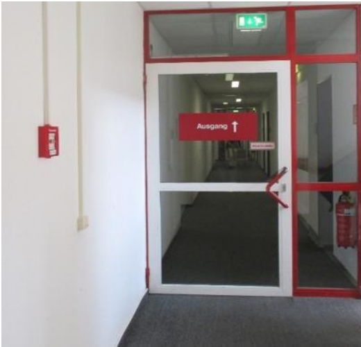
Abbildung 20: Der Taster für die Öffnungsautomatik ist weder als solcher markiert noch kontrastreich abgesetzt. (Quelle: Eigenes Foto)
