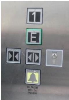
Abbildung 27: Taktile Bedienelemente in der Cäciteria an der Cäcilienschule (Quelle: Eigenes Foto)
