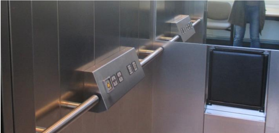
Abbildung 7: Aufzug mit horizontalem Bedientableau, Geländer, Spiegel und Klappstuhl im Standesamt Oldenburg (Quelle: Eigenes Foto)
