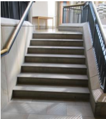
Abbildung 24: Treppenstufen ohne Markierungen im PFL Oldenburg (Quelle: Eigenes Foto)
